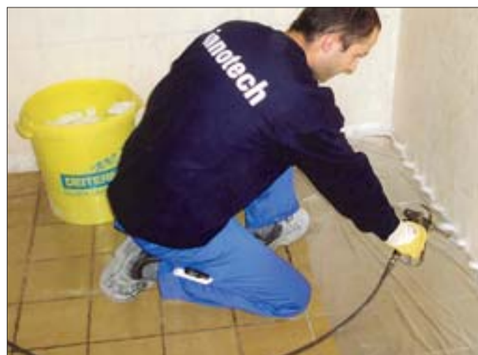
Modernste Abdichtungsverfahren garantieren höchste Qualität.
